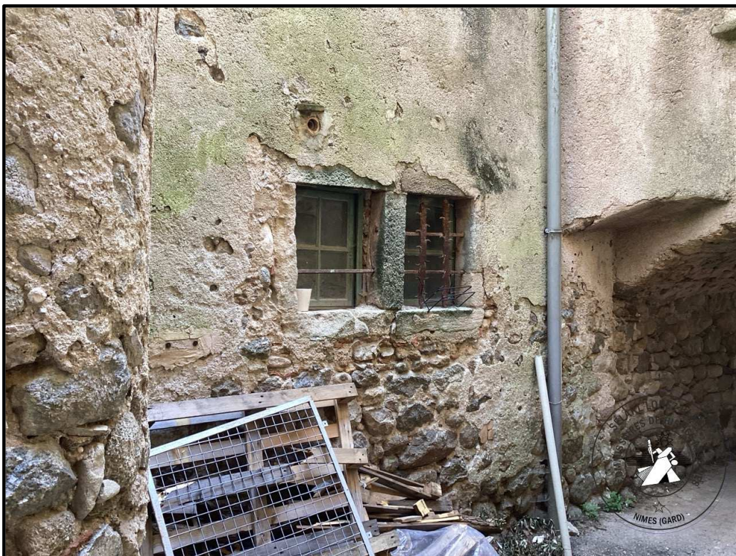
La façade OUEST de l'immeuble est crépie, largement écroulée en soubassement faisant apparaître les pierres apparentes.
