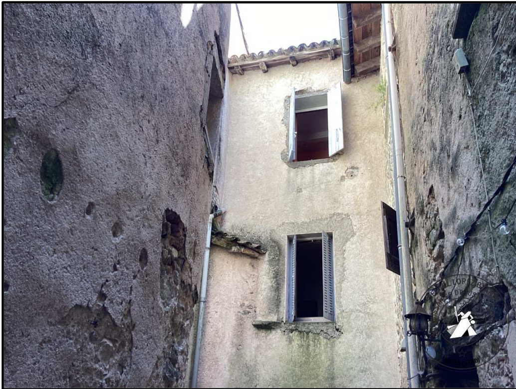
La façade OUEST de l'immeuble est crépie, largement écroulée en soubassement faisant apparaître les pierres apparentes.
